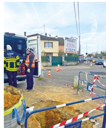
Du mercredi jusqu'au vendredi, les techniciens GRDF ont réussi à rétablir le gaz chez plus de 800 clients.
