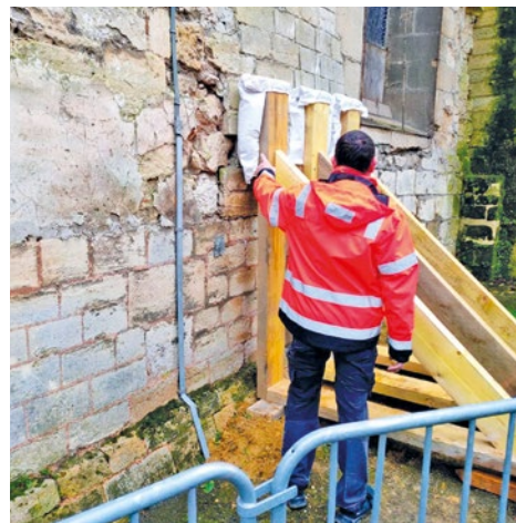
Des coussins de ciment ont été disposés entre le bois du contrefort et la façade.
