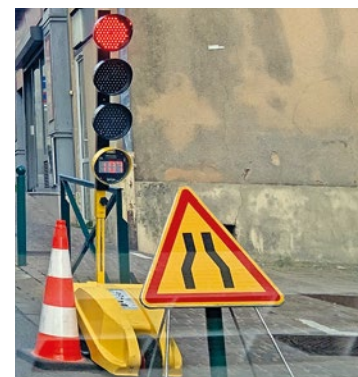
Les travaux de la rue des Perrons permettront de faciliter et de sécuriser tous les modes de déplacement grâce à la réfection de la chaussée et à l'élargissement des trottoirs.
