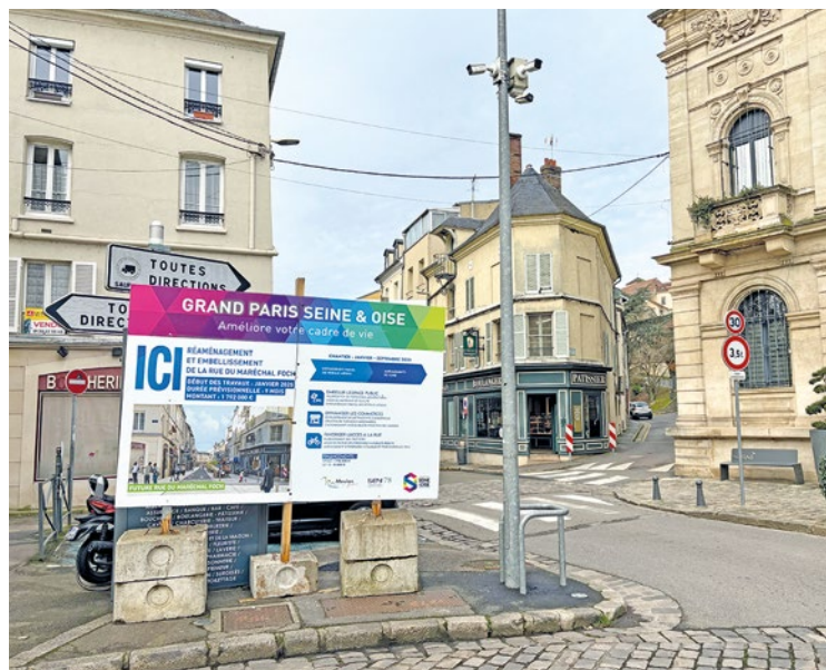
« Les commerces et les logements restent, eux, accessibles pendant toute la durée des travaux, avec des accès « pièdes propres » », précise la municipalité.
