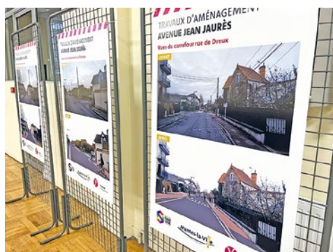
Enfouissement des câbles électriques, accessibilité, l'avenue Jean Jaurès entrera « dans l'ère moderne » à la fin des travaux prévue pour mars 2026.
