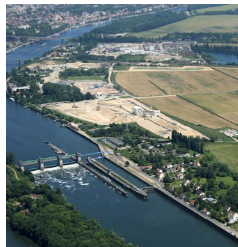
La phase 1 des travaux du port débutera en 2025.
