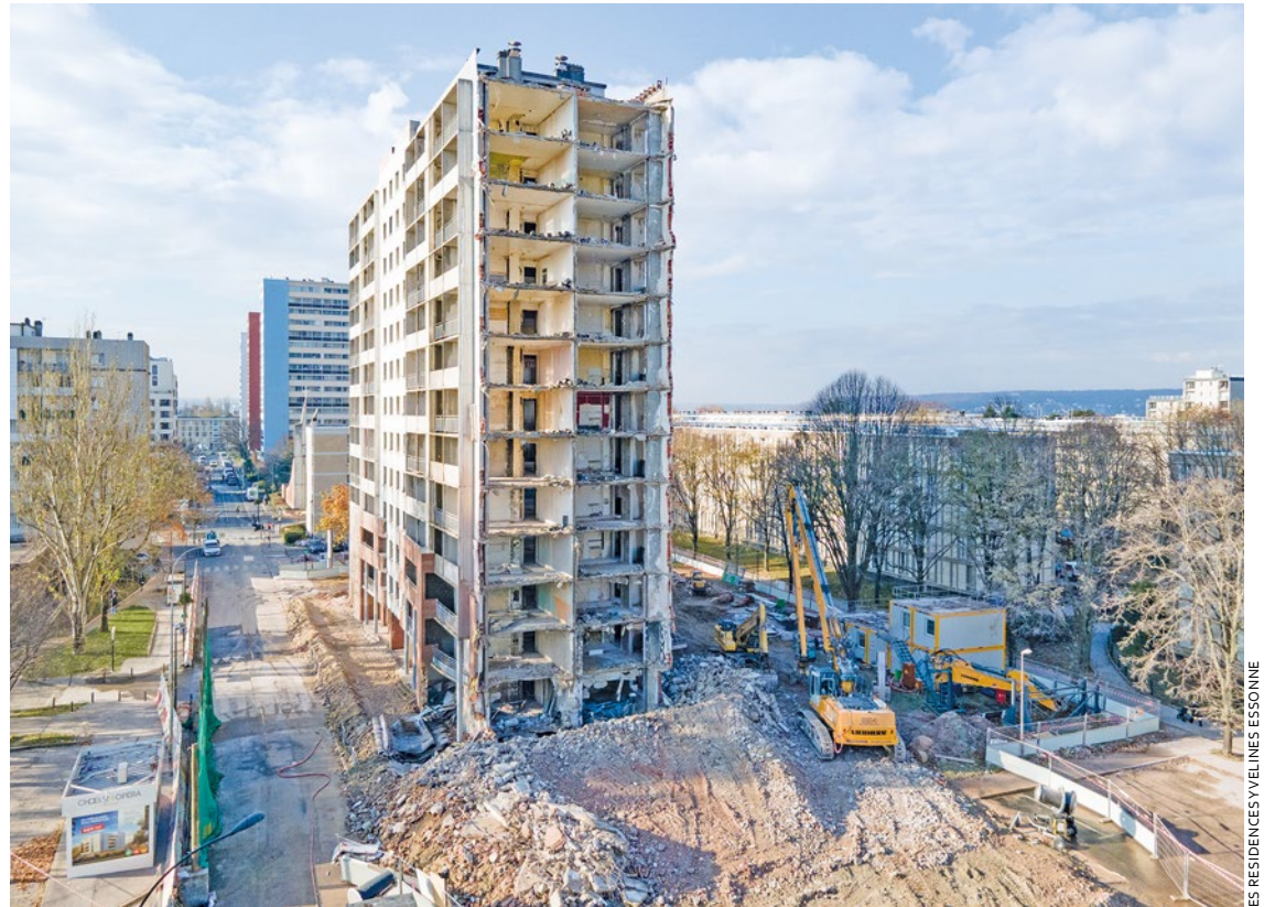
Melchiorre SA s'est déjà occupé d'un chantier équivalent à Massy (Essonne). La tour faisant 13 étages.
