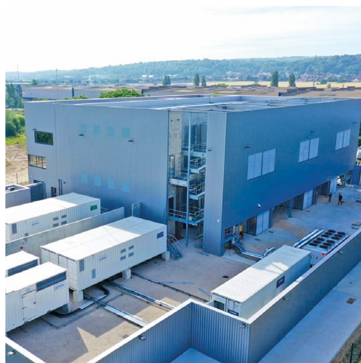
Thésée Datacenter a lancé son activité à Aubergenville en septembre 2021.
