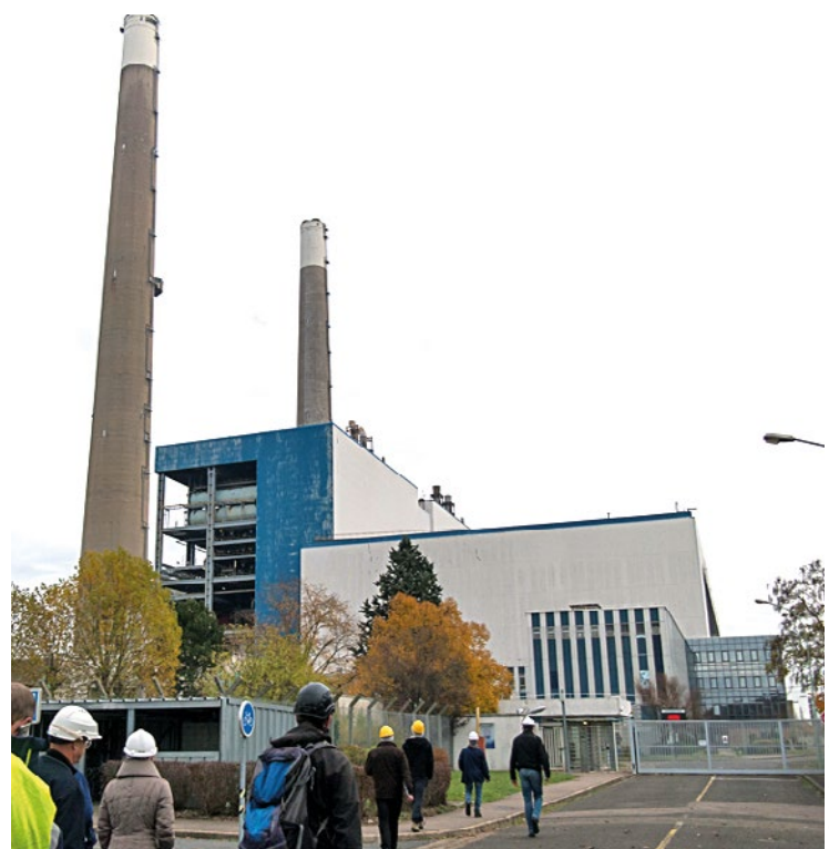
Un « projet de thermique » serait également dans les tuyaux à long-terme.
