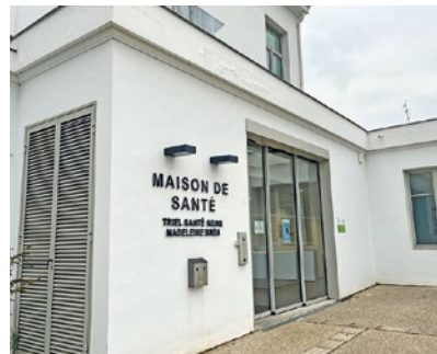
La Maison de Santé de Triel-sur-Seine s'est déjà plainte sur les réseaux sociaux à propos de malfaçons du bâtiment.
