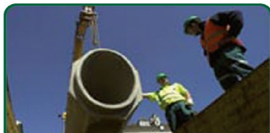
Assainissement, génie civil adduction d'eau potable
