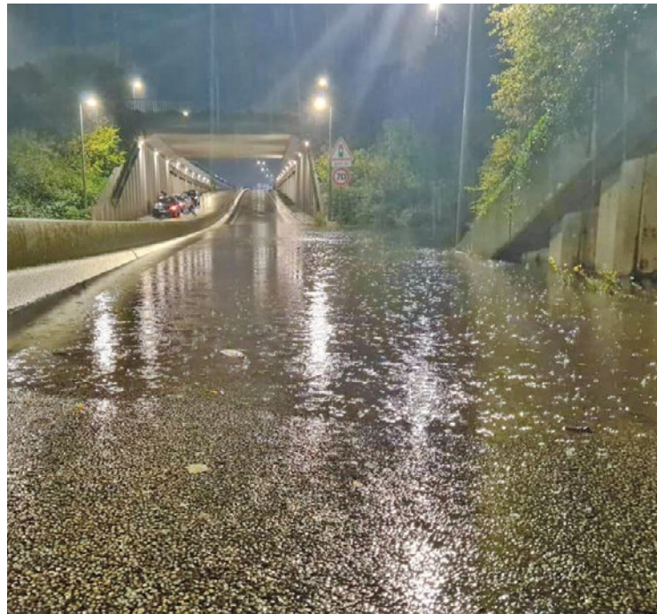
Plus de peur que de mal, notamment à Orgeval, malgré quelques accumulations d'eau dans certaines portions de la route de Quarante Sous.
