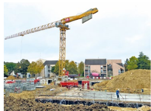
Au programme de ce vaste chantier, la construction d'un nouveau bâtiment dédié aux patients atteints de la maladie d'Alzheimer.
