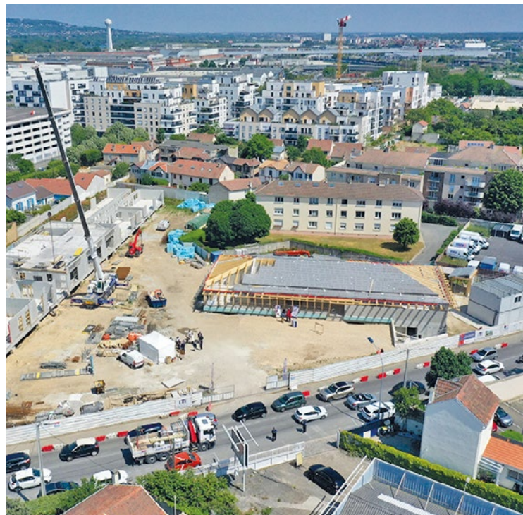
Le chantier a démarré en décembre 2022.
