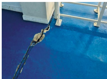
« C'est une fissure d'environ six centimètres qui laisse présager une fragilisation du bâtiment », explique le maire Fabien Aufrechter (LREM).
