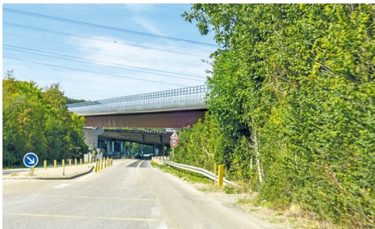
« Il n'y aura plus de travaux sur le nouveau tablier, mais sur les anciens, explique la Sanef. Le nouveau tablier est mis en service pour poursuivre le projet »
