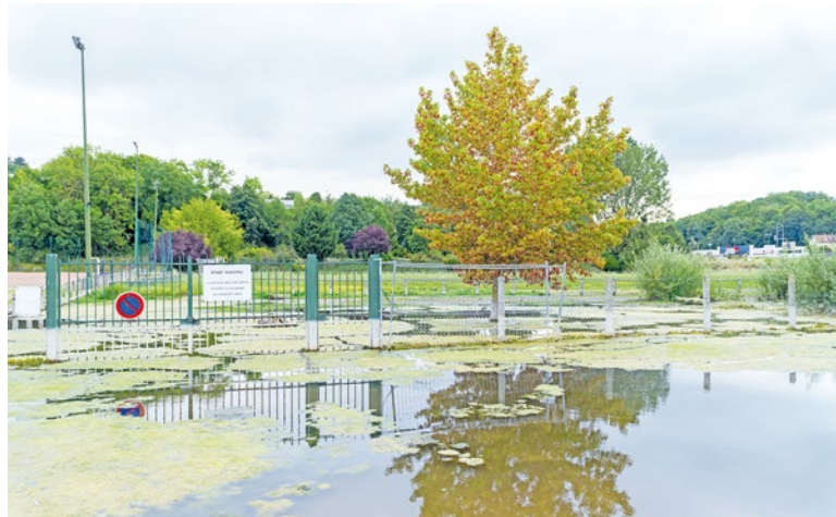
Pour Veolia eau, la situation n'est pas une surprise, au vu de l'emplacement du stade des Aulnes. « Historiquement, le stade et toute cette zone-là est une tourbière », indique Eric de Saint-Martin, directeur territorial des Yvelines pour Veolia eau.
