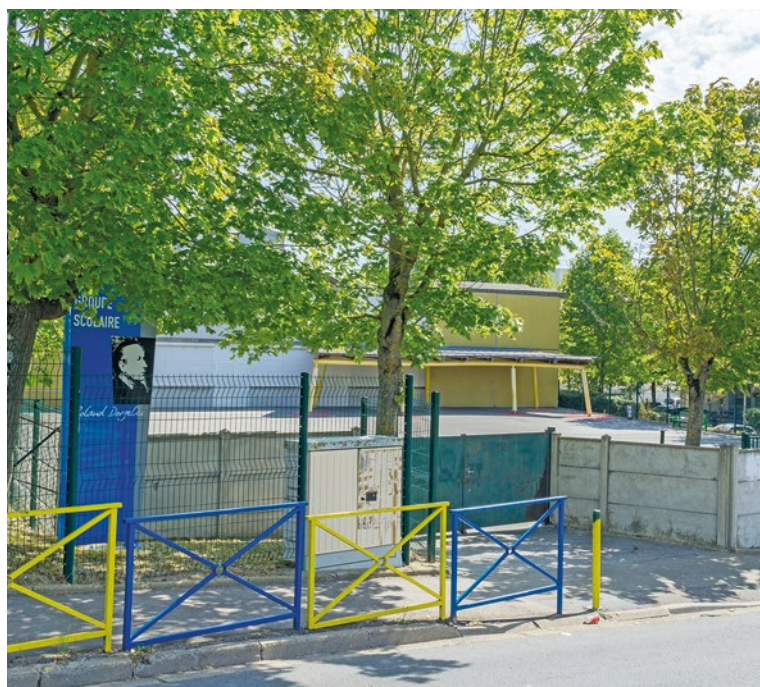
« Nous avons actuellement trois bâtiments, au Sud, le groupe scolaire Dorgelès qui va être entièrement démoli avec la cantine scolaire pour donner place à une nouvelle construction », détaille la maire Catherine Arenou (DVD).
