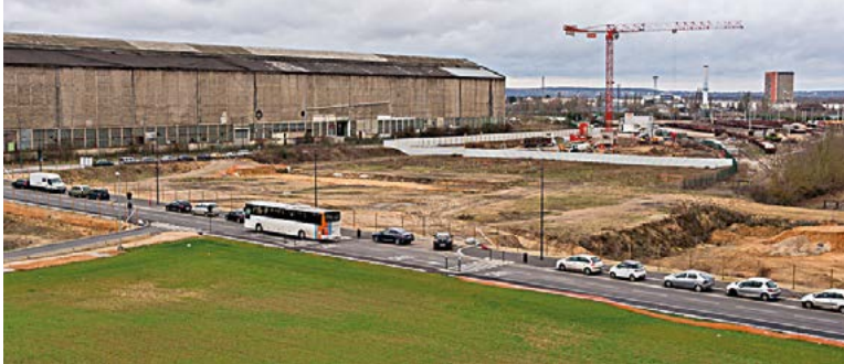
Les terrains de la SNCF devaient pourtant accueillir, à côté de la halle Sulzer, un groupe scolaire de 12 classes et une résidence de 177 logements réalisés par le promoteur Marignan.
