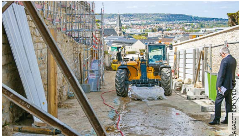
Les travaux de la rue de la Tournelle devraient être achevés d'ici septembre 2016.
