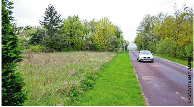
Dix nouveaux logements vont être construits rue Vieille Côte.
