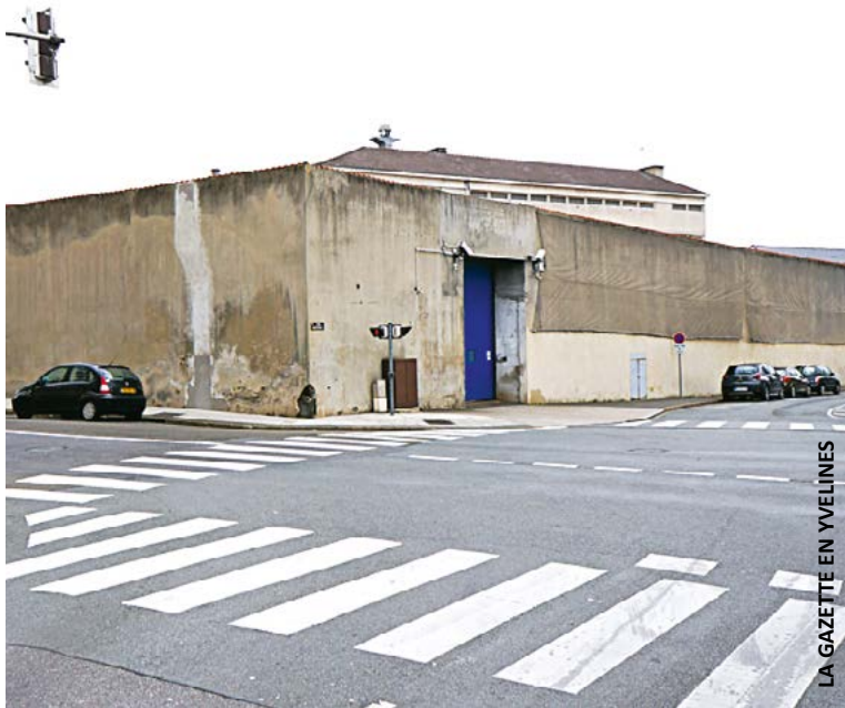
Les flammes se sont déclarées dans une cellule située au deuxième étage de la maison d'arrêt.
