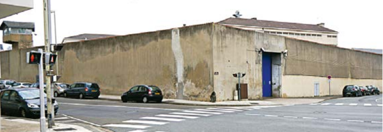
L'incendie a occasionné quelques dégâts matériels à l'intérieur des cuisines de la maison centrale de Poissy.
