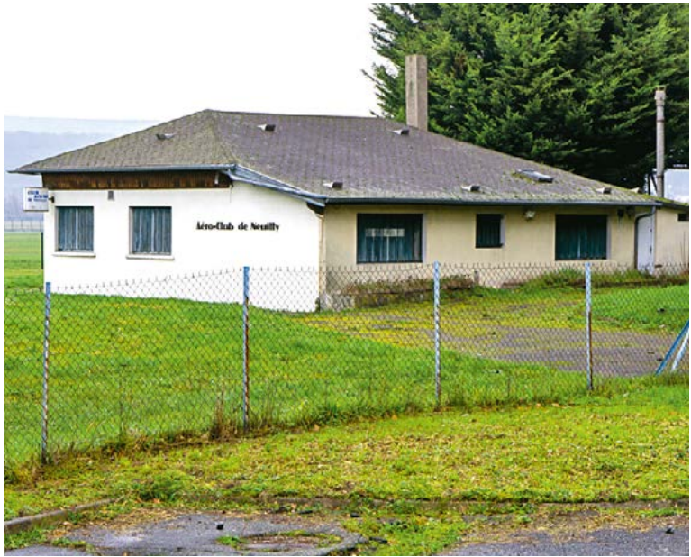
L'emplacement du futur établissement est en bord de piste, à l'endroit exact où se tenait déjà un précédent restaurant, il y a quelques décennies. Le bâtiment ci-dessus sera prochainement démoli.
