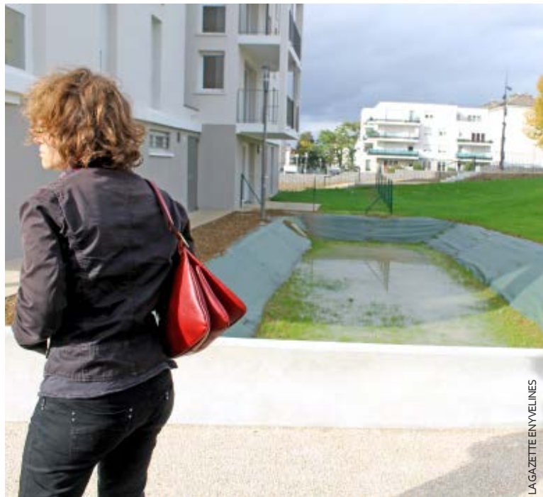
Les noues plantées et les bassins filtrants permettent de réutiliser les eaux pluviales. .
